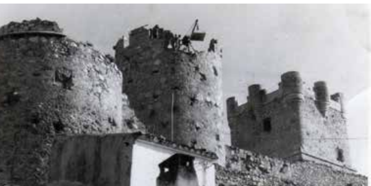
▲ Obras de restauración en 1960
